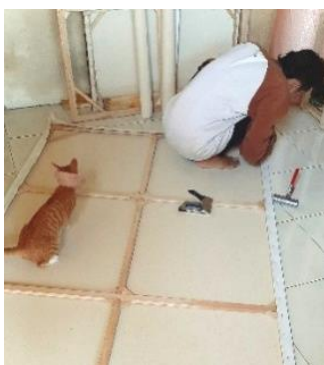
Gambar 3. Pemasangan kain kanvas (Dokumen penulis, 2021)
